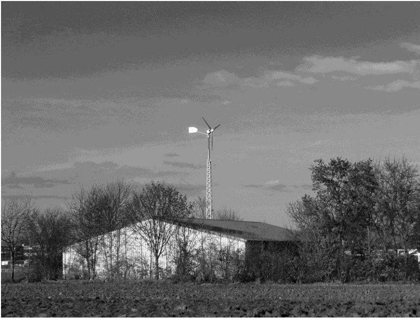
Abbildung 1: Kleinwindkraftanlage mit 5 kW Leistung auf 18 m Mast
